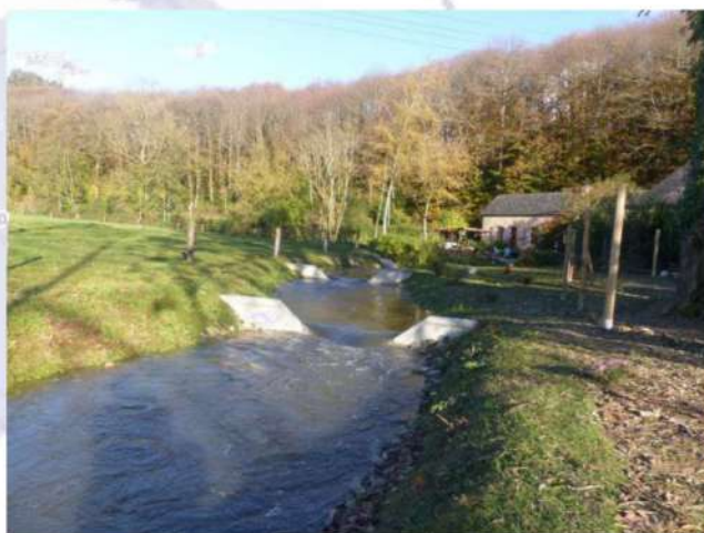
La rivière de contournement du Moulin du David à l'issue des travaux
